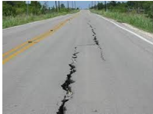
Longitudinal Cracking
